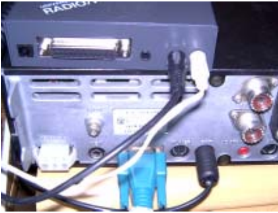
(写真4 クロスケーブルにも PC 側にフィルターを入れた)
